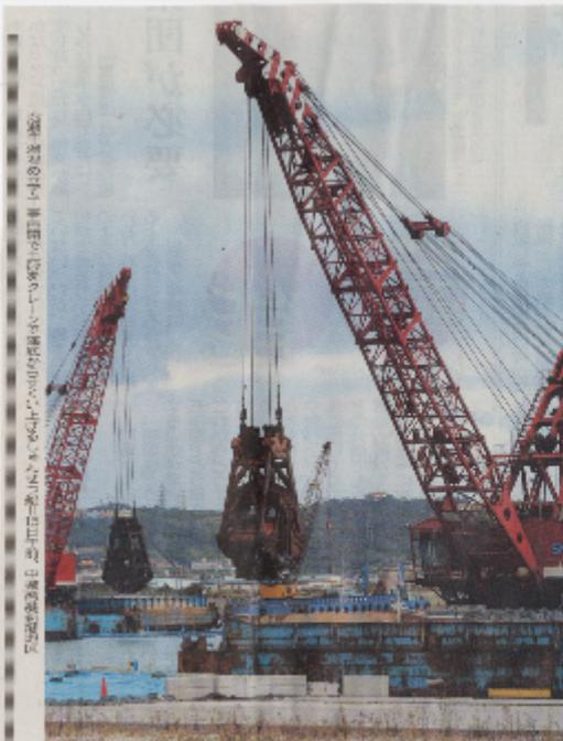
泡瀬埋め立て工事の現場。大型クレーンが土砂を吊り上げ、海中に投入している。
