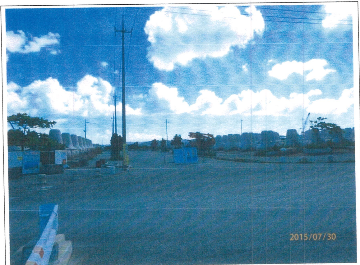
写真5. 肝高公園（写真の左側）の西側一帯の工事現場とブロック
