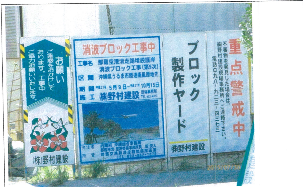
写真1. 肝高公園の北西側の区画の「野村建設」の工事現場を示す看板
